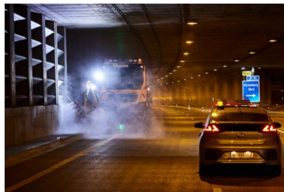
Tunnelreinigung A5/ S1 © Bonaventura/ Bernd Geppert
