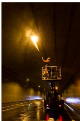
Tunnelreinigung im Frühjahr © Bonaventura/ Petra Rautenstrauch Downloadlink
